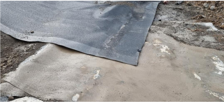
Kuva 18. Suojakalvo limitettiin erotusrakenteen (2019 rakennettu) kalvon päälle. ”
